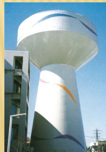
上青木浄水場配水塔
