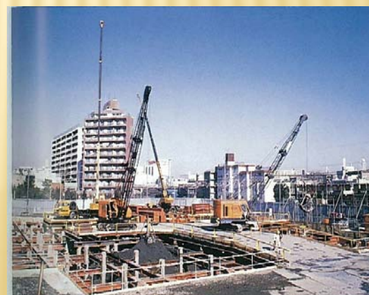
横曽根浄水場建設風景（平成元年）
