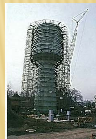
石神配水場配水塔（昭和53年）
