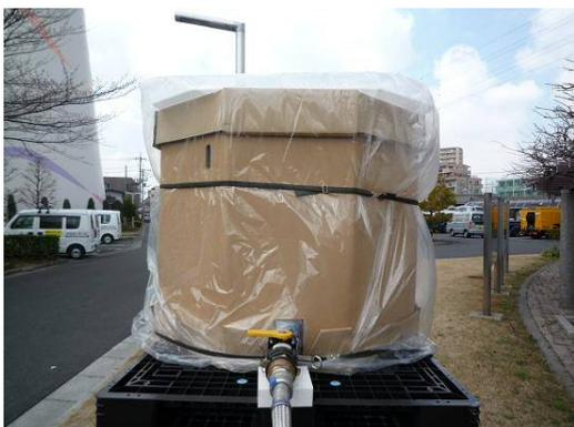
風で⑨ビニルカバーが飛ばない様、④貯水タンク本体の上下に 2 本、⑩バンドを取り付けます。
