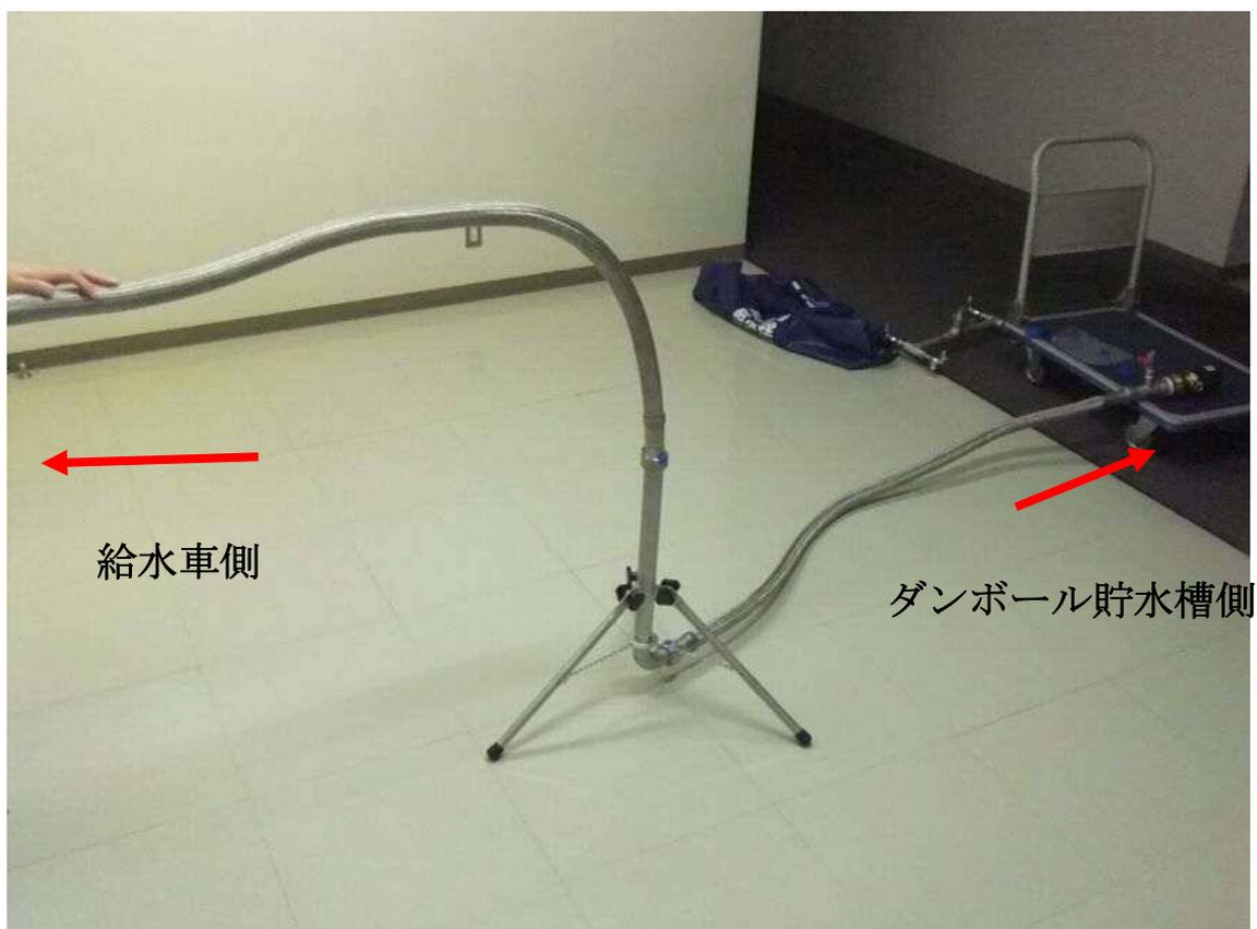
⑨ 給水車とダンボール貯水槽を接続する場合のレスキュータップの完成図です。
