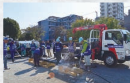
川口市総合防災訓練における ライフライン復旧訓練 11/6 (日)
