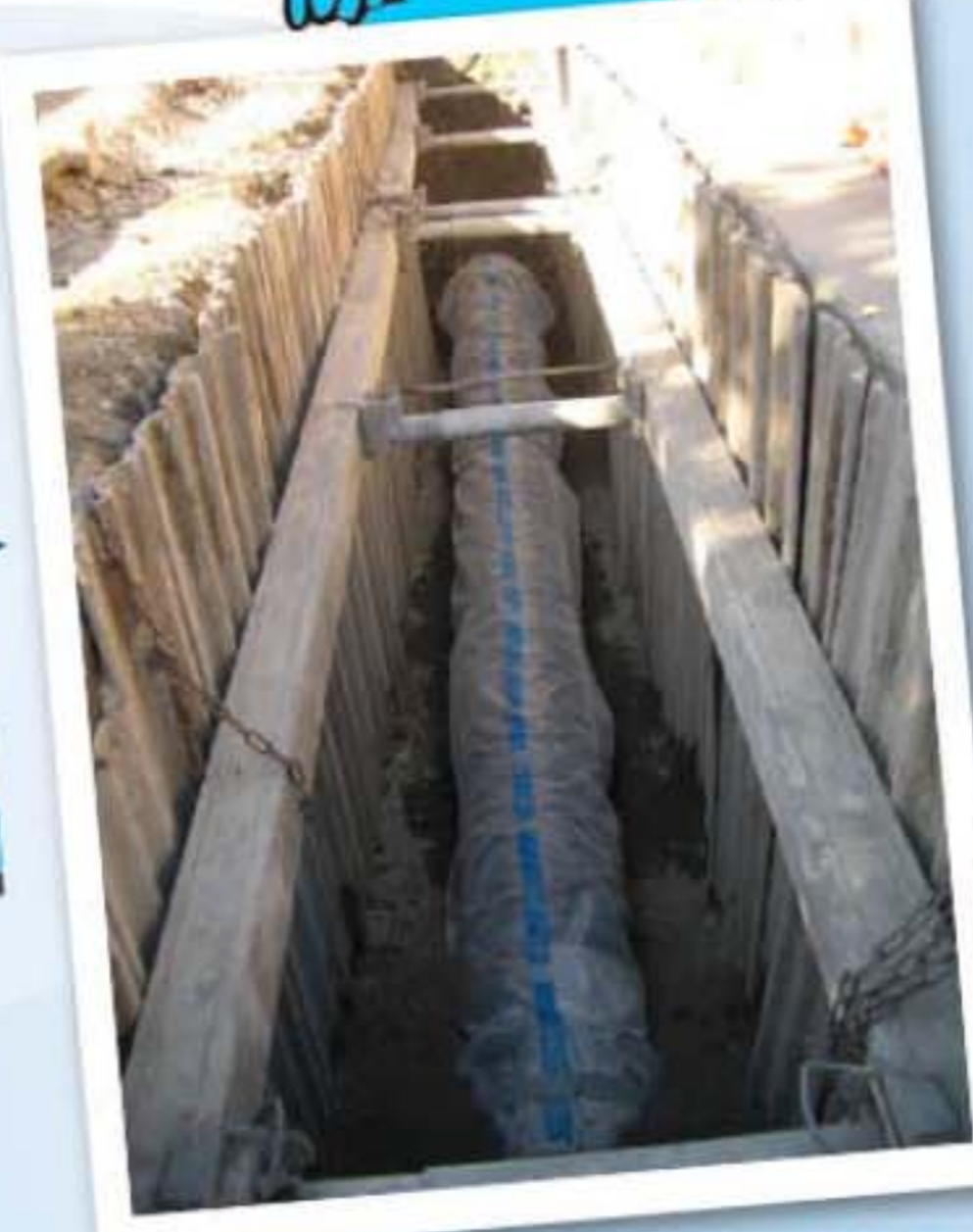
▲耐震管への布設替え
