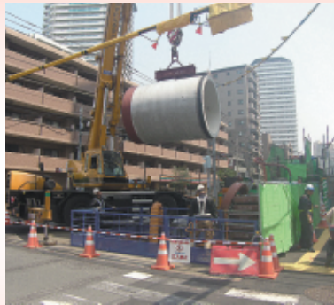
▲雨水貯留管設置工事
