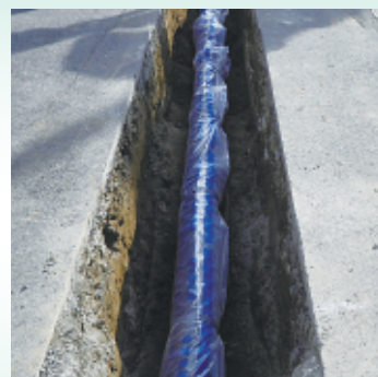
▲耐震管への布設替え
