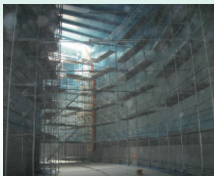
▲配水池内部塗装工事
