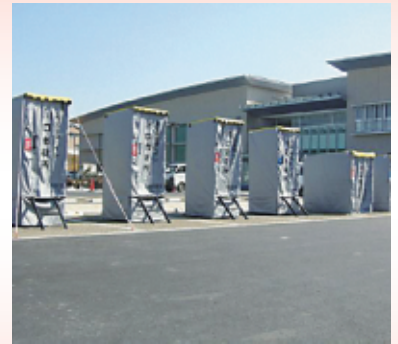
▲災害用マンホールトイレ設置 (写真は平成19年度に設置した戸塚スポーツセンターのもの)
