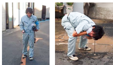
▲漏水調査の様子
