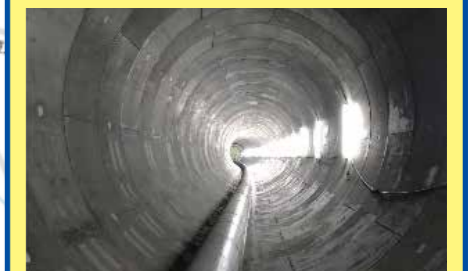
雨水貯留管の内部の様子
