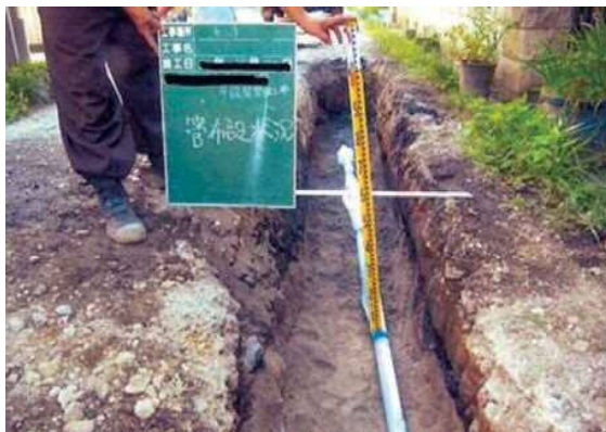
給水管布設替状況
