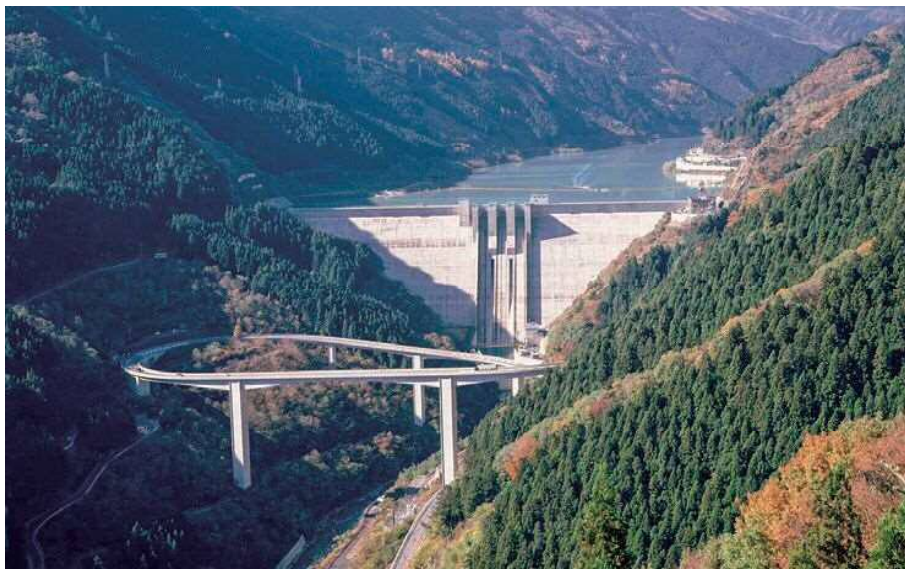
滝沢ダム（写真：独立行政法人 水資源機構提供）
