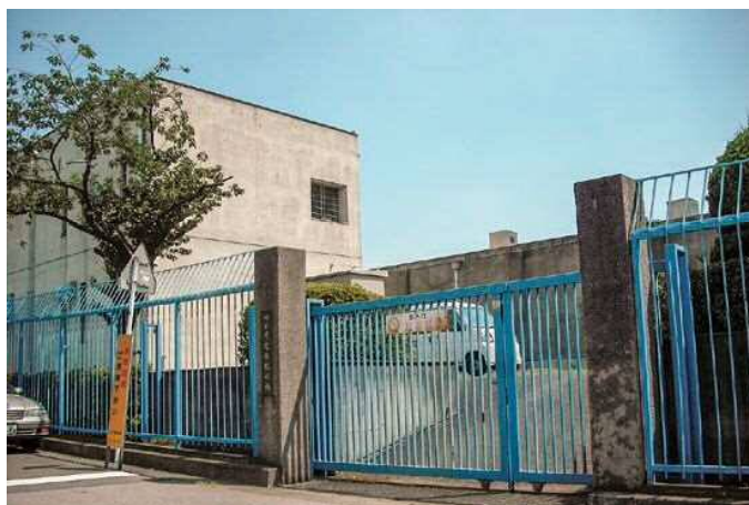
浄配水場のフェンス状況(芝園配水場)
