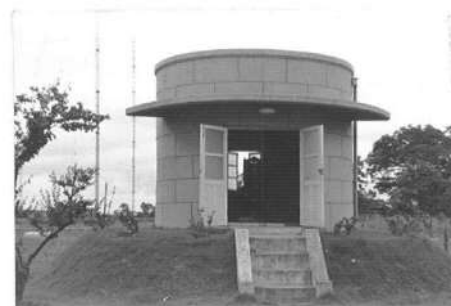
第1号井（上青木浄水場）
