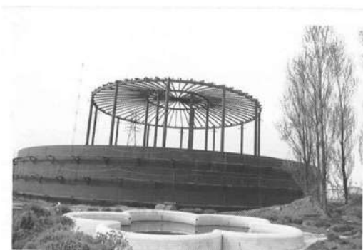
上青木浄水場受水池建設(昭和45年頃)
