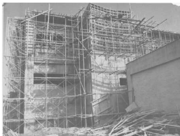
鳩ヶ谷浄水場管理棟築造
