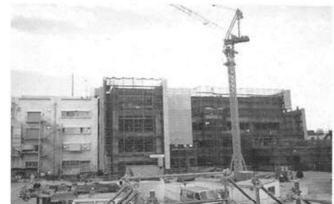
上青木浄水場管理棟築造（平成7年頃）
