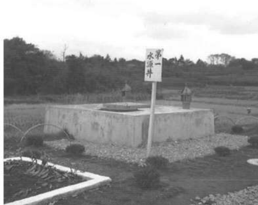
第1号水源井（鳩ヶ谷浄水場）
