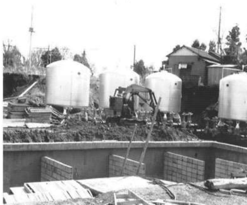
神根浄水場建設(昭和38年頃)
