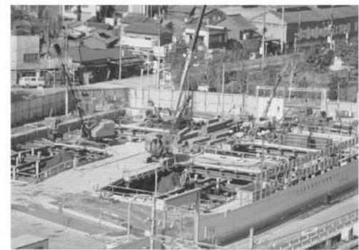
南平配水場建設（平成元年頃）
