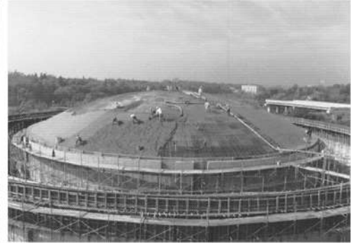
石神配水場配水池建設
