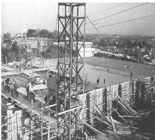
新郷浄水場第1配水池建設(昭和41年頃)
