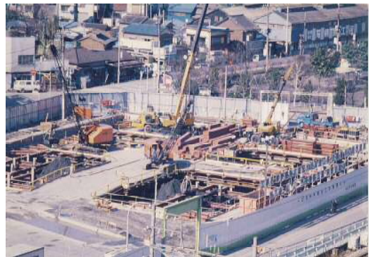
南平配水場建設（平成元年頃）
