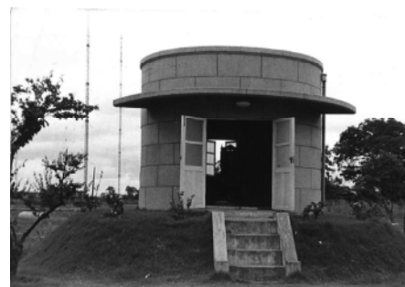
第1号井（上青木浄水場）
