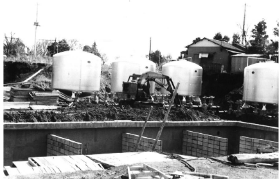
神根浄水場建設（昭和38年頃）
