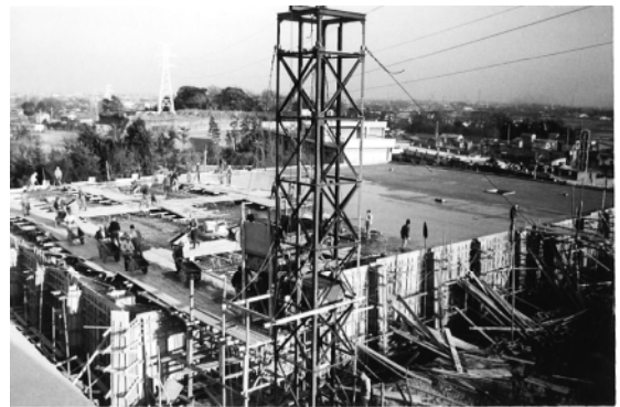
新郷浄水場第1配水池建設（昭和41年頃）
