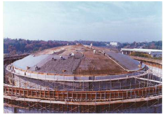
石神配水場配水池建設
