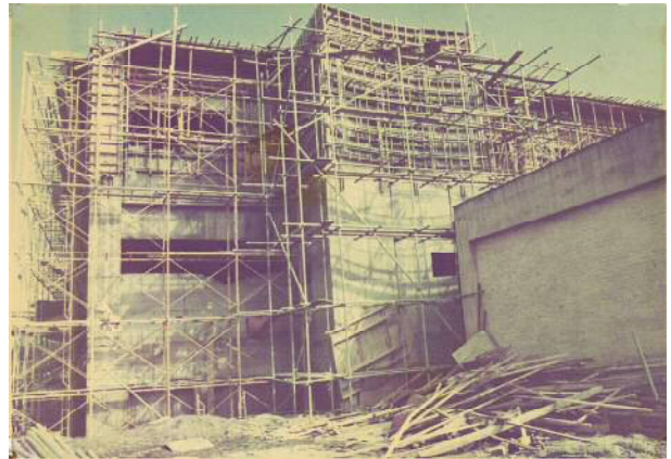
鳩ヶ谷浄水場管理棟築造
