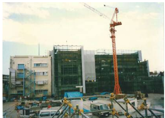
上青木浄水場管理棟築造（平成7年頃）
