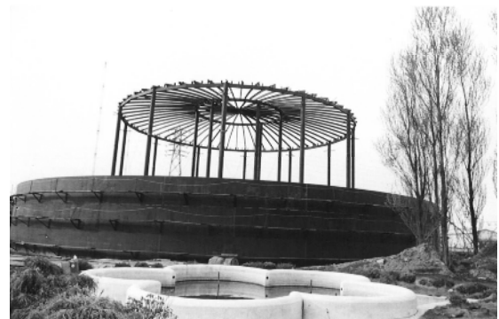
上青木浄水場受水池建設（昭和45年頃）
