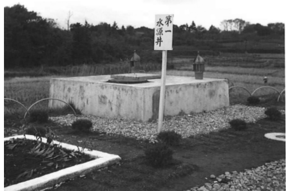
第1号水源井（鳩ヶ谷浄水場）
