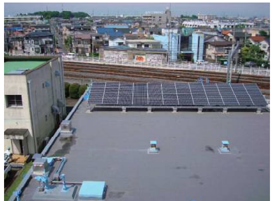
太陽光発電装置（芝園配水場）
