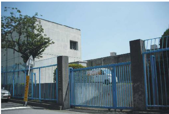
浄配水場のフェンス状況
