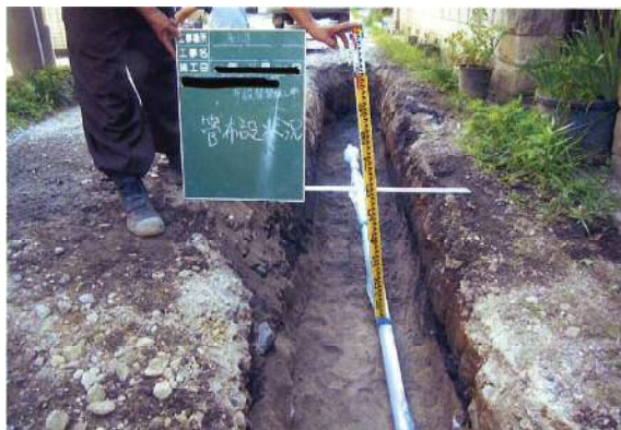
給水管布設替状況
