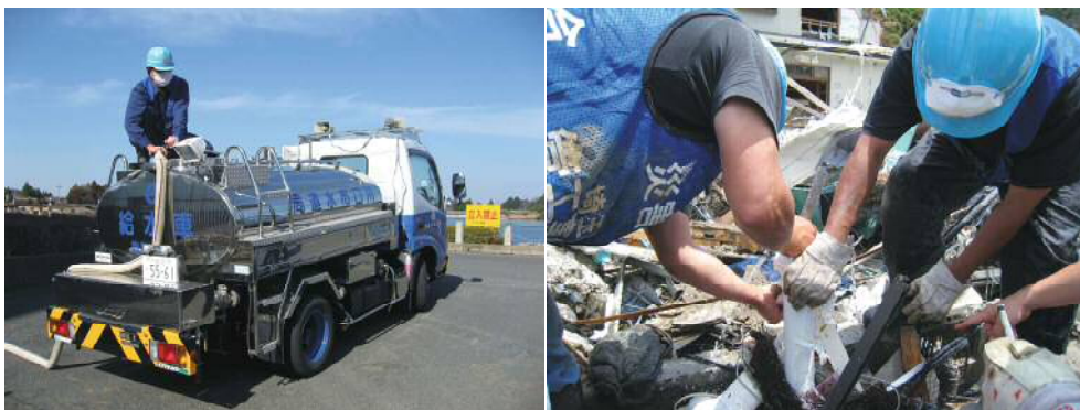
東日本大震災（平成23年3月水戸市派遣〈応急給水〉 平成23年6月石巻市派遣〈管路復旧〉）
