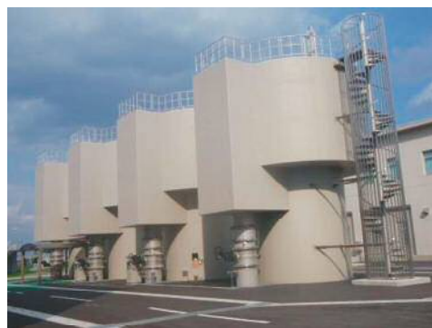
高度浄水処理施設（オゾン接触池：新三郷浄水場）
