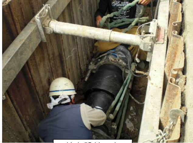
管布設替工事
