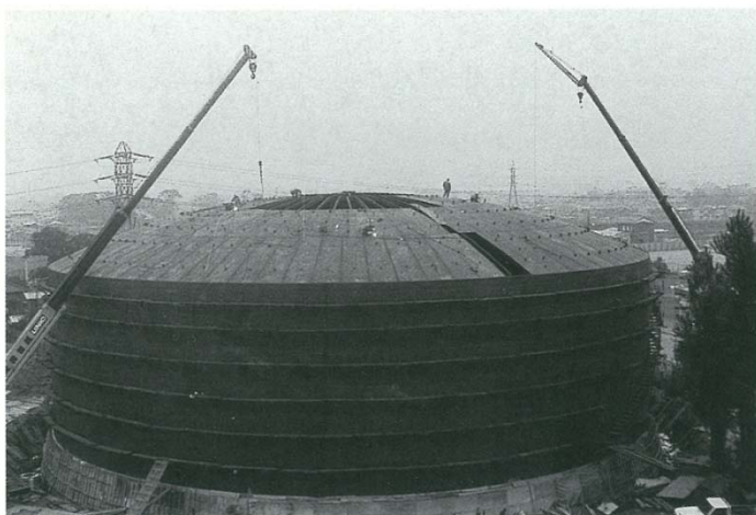
上青木浄水場県水受水池建設（昭和45年頃）
