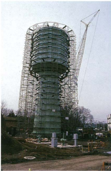
石神配水場配水塔(昭和53年頃)
