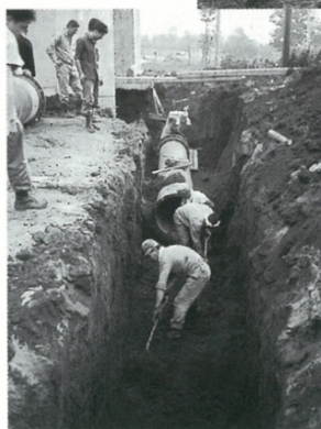
新郷浄水場県水受水用送水管布設(昭和43年頃)
