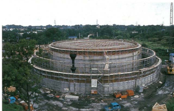
石神配水場配水池(昭和53年頃)
