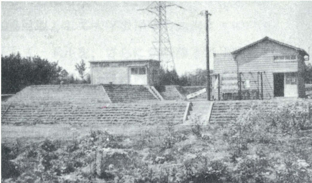
簡易水道新郷浄水場完成(昭和36年頃)
