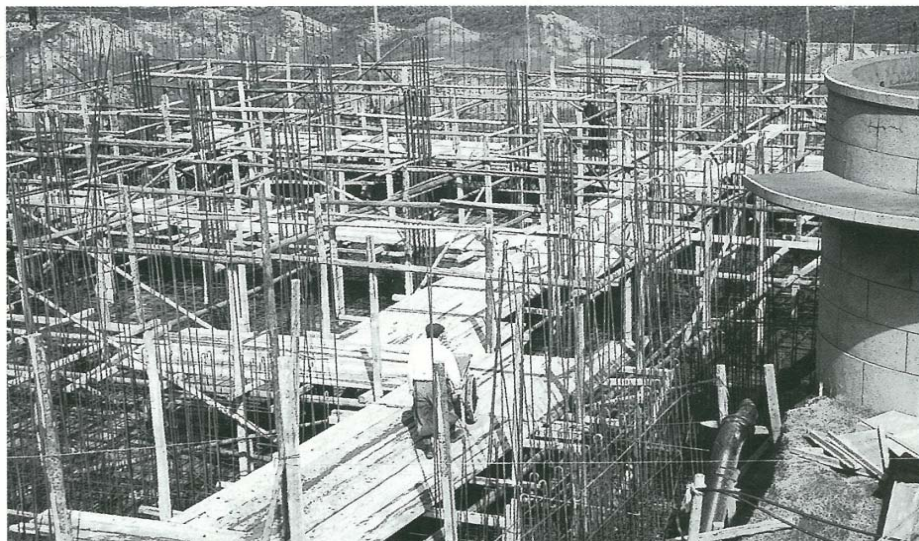
第2配水池建設工事 上青木第2浄水池工事の様子(昭和34年頃)
