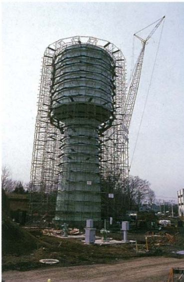
石神配水場配水塔(昭和53年頃)
