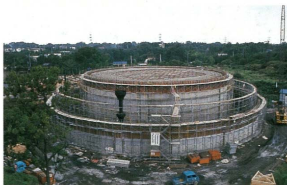
石神配水場配水池(昭和53年頃)
