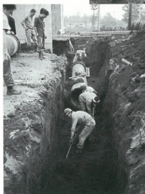
新郷浄水場泉水受水用送水管布設(昭和43年頃)
