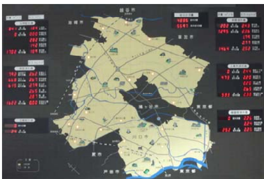
配水状況表示盤
