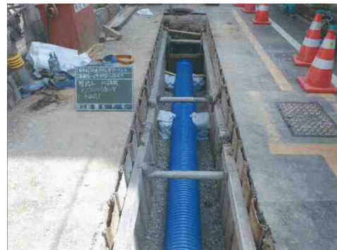
【下水道管の布設替事例】
