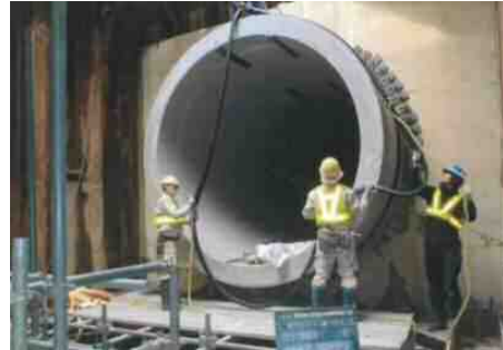
【内径 3m の雨水貯留管】
