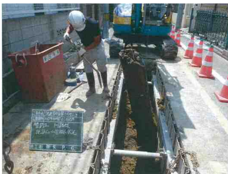
古くなった下水道管の撤去
