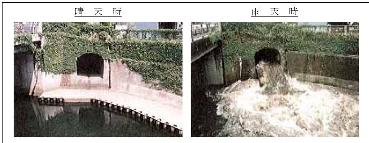
図2 雨水吐き口からの未処理放流水流出状況（他都市の例）
