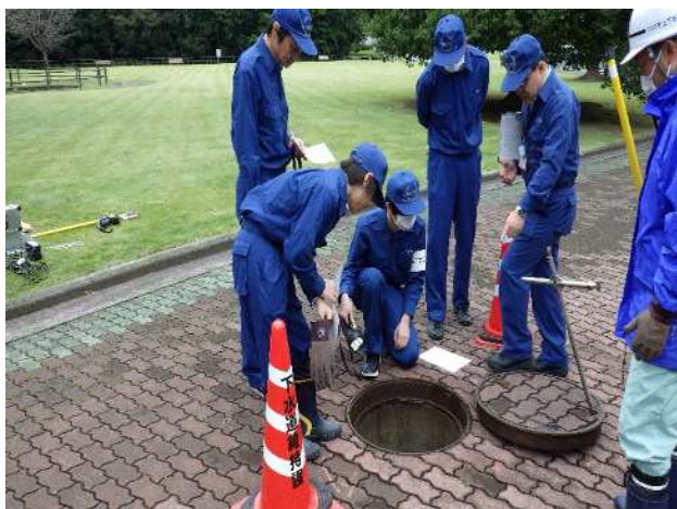
⑤人孔点検訓練 (下水道班)
