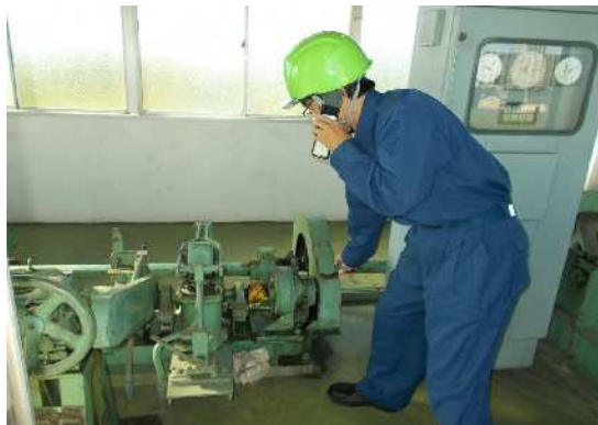
⑥外ゲート動作確認訓練（ポンプ場班）
