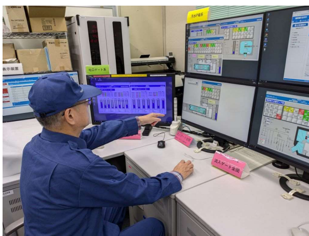
⑥無人ポンプ場の遠隔操作訓練（ポンプ場班）
