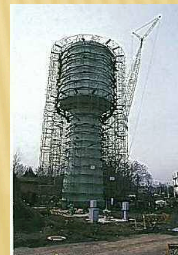
石神配水場配水塔（昭和53年）
