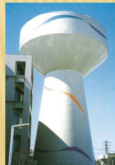
上青木浄水場配水塔
