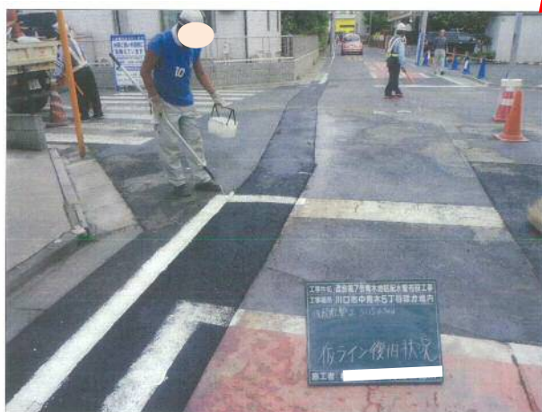
仮の舗装も終わりました。
