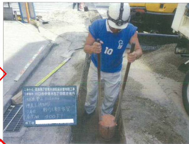
埋め戻した砂を締め固めています。
