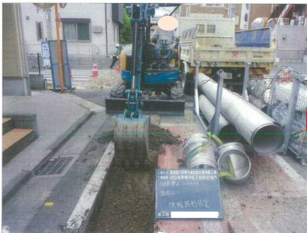
掘り始めました。右側シルバーの管が仮設管です。
