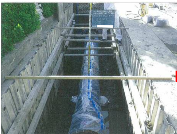
所定の位置に管の布設が完了しました。
