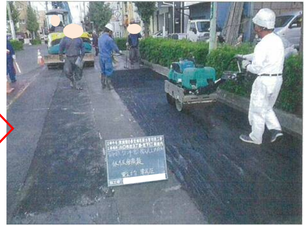
埋め戻し・仮舗装を施工して完了です。
