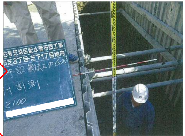
所定の深さになっていることを確認します。
