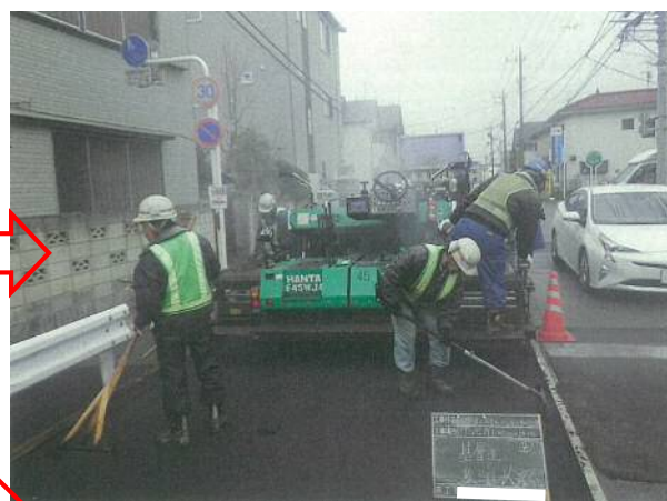
アスファルト合材の敷き均しをしています。
