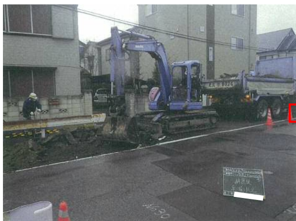
古い舗装をめくっています。
