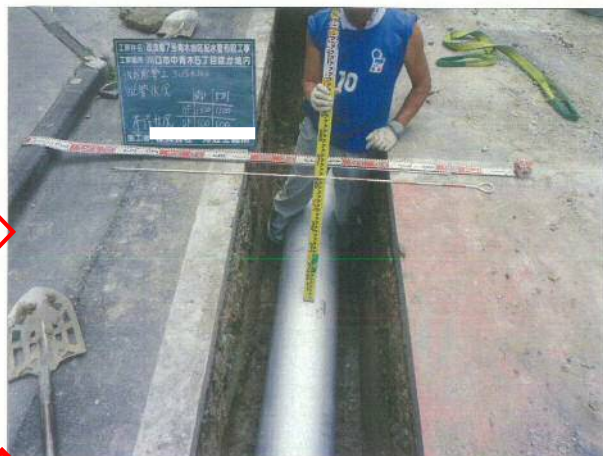
所定の位置深さに布設し終えたところです。
