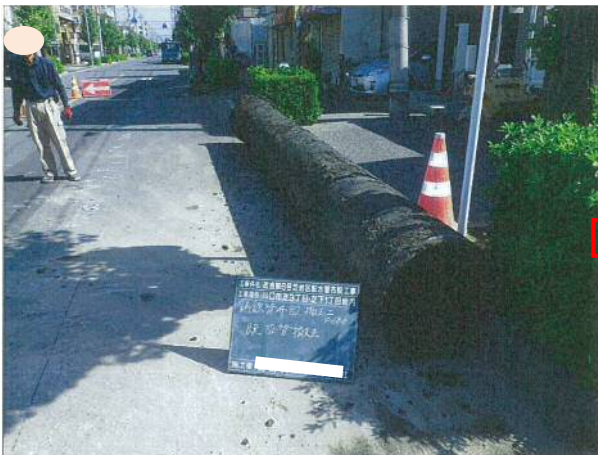
途中、古い水道管を撤去します。
