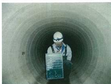
【更生後の下水道管の内部】
