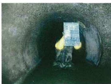
【更生前の下水道管の内部】
