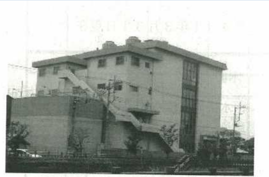
元郷排水ポンプ場（ポンプ場管理センター）
