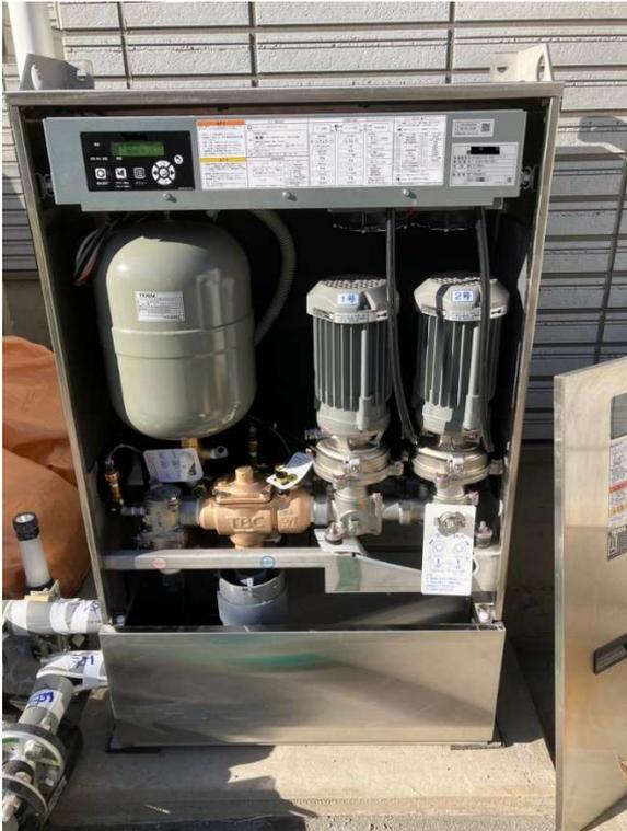
加圧装置が増圧ポンプの場合、事前協議通りの型番及び設置位置の確認、露出配管部分は保温措置がされていること（竣工検査までに施工されていれば構いません。）、増圧ポンプの一次側及び二次側にバルブ及び防振継手が設置されていること、ポンプカバーを外して増圧ポンプ内の吐水口空間が取れている等の施工確認をいたします。ポンプカバーの取り外しが行えるよう鍵等の準備をお願いいたします。
