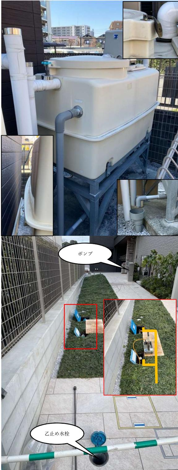
加圧装置が貯水槽の場合、事前協議通りの型番（容量）及び設置位置の確認、露出配管部分は保温措置がされていること（竣工検査までに施工されていれば構いません。）、貯水槽と壁等の離隔距離が保たれ六面点検が可能であること、貯水槽蓋に南京錠等で施錠されていること、オーバーフロー管とホッパーの吐水口空間が取れている等の施工確認をいたします。
