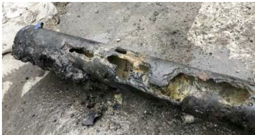
▼設置から44年が経過した水道管
